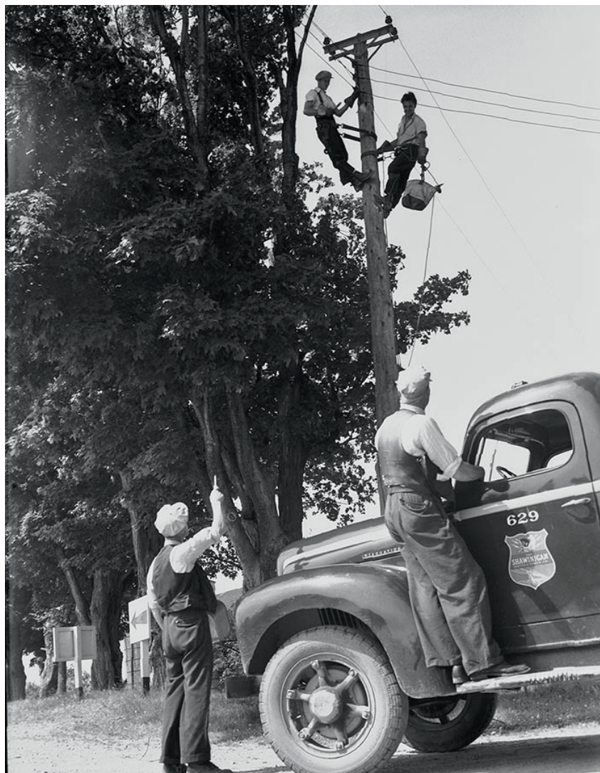
Monteurs de ligne en 1945
